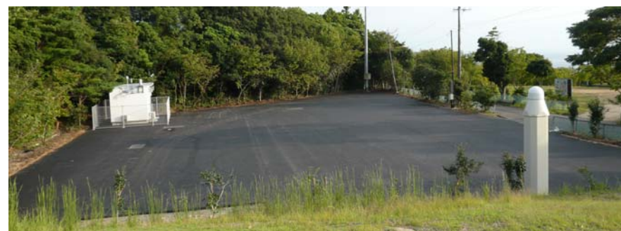
竣工後の全景
