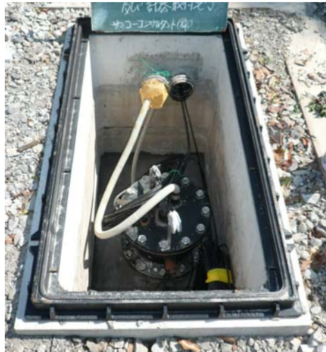
完成後の観測井口元状況
