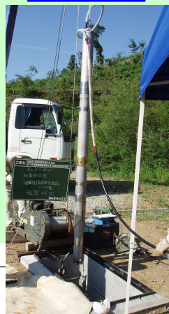
孔3 (掘削深度:30m) 地震計 水位水温計
