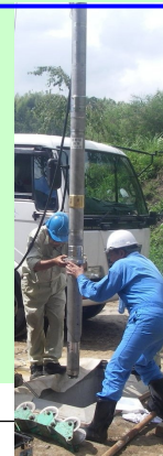
孔1 (掘削深度:620m) 傾斜計 地震計 水位水温計
