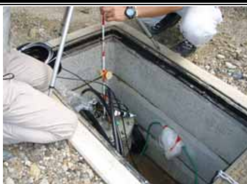
孔1・2・3共通水位計・水温計設置状況
