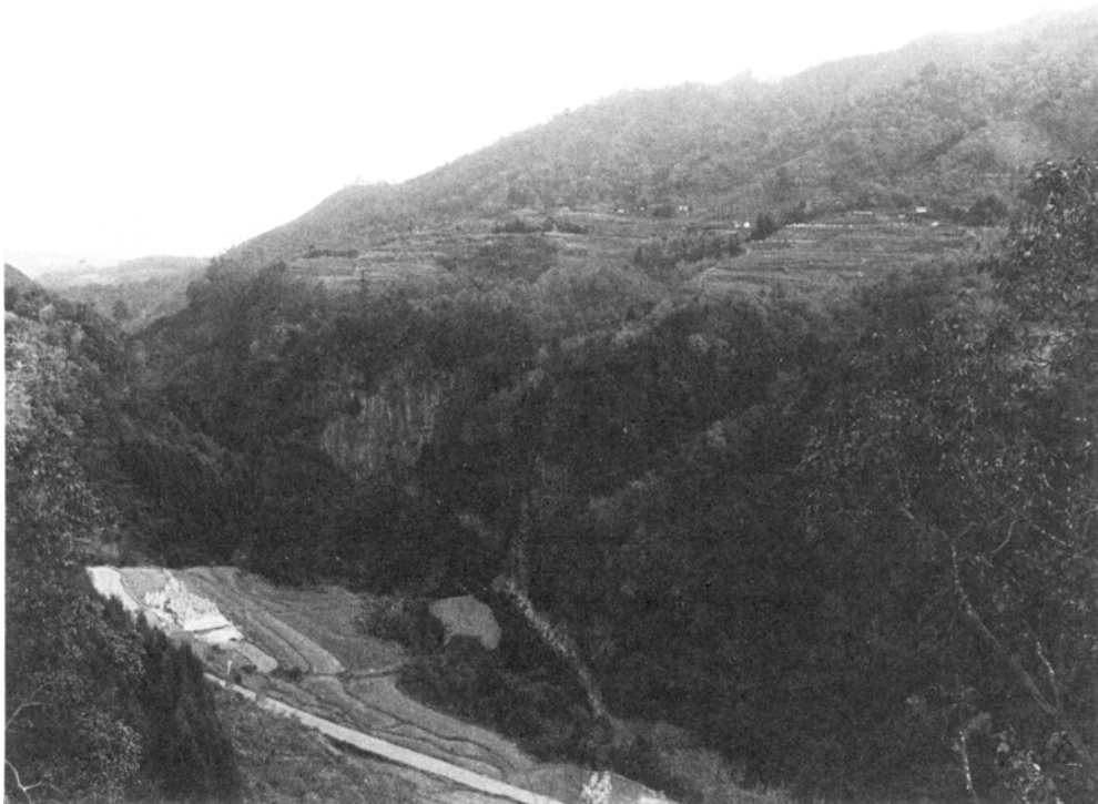
第3図 奥岳川の峡谷を埋めたAso-4火砕流のつくる段丘状地形．柱状節理のみえる絶壁は強溶結部，その上，部落までの緩斜面は気相晶出帯と非溶結部との岩石からなる．背後の山地は祖母山火山岩類からなる．
