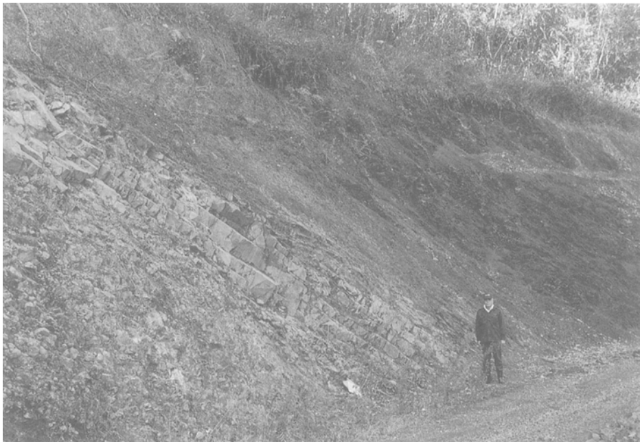
第25図 椎原層 Sb3 部層中の礫岩と頁岩の境界部(野津町溜水西方1km)
