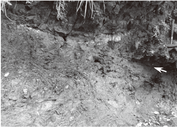
第 10. 3 図 地すべり面の例（新居浜市別子山草原の南西約 800 m, 第 10. 4 図の L3 地点） ハンマーの長さは 33 cm. 西を向いて撮影. ハンマーの位置から上が地すべり岩塊で、それより下は破碎された泥質片岩からなる。境界面のトレース（白矢印）は直線的である。
