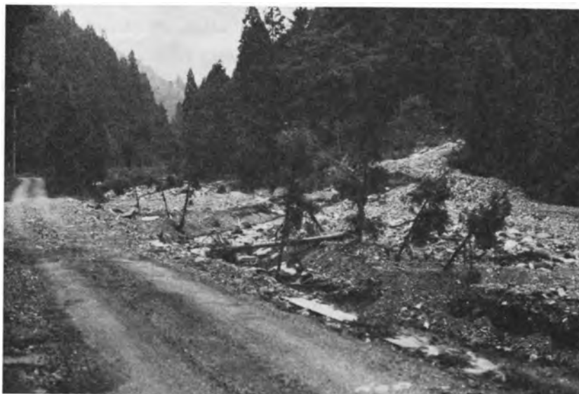
第52図 昭和56年7月の土砂流出 板取村三洞（昭和56年8月9日撮影）
