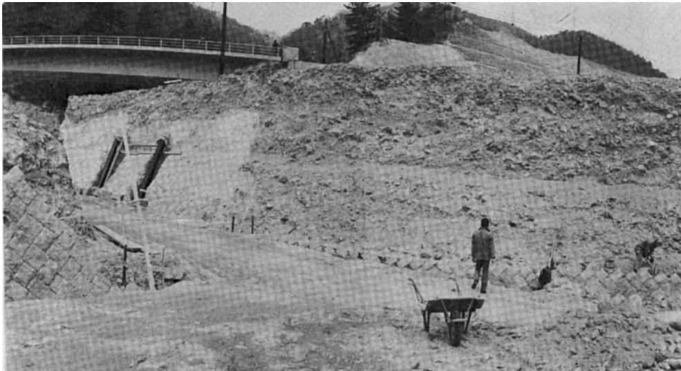
第31図 鶴甲団地造成時に露出した大月（土橋）断層（昭和44年） 左側の白い部分が破碎花崗岩，右側が崖錐状角礫層。
