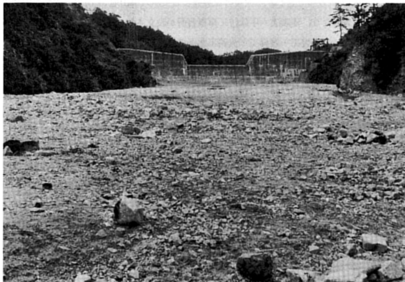
第60図 昭和42年災害前後の五助ダム（六甲砂防事務所）
