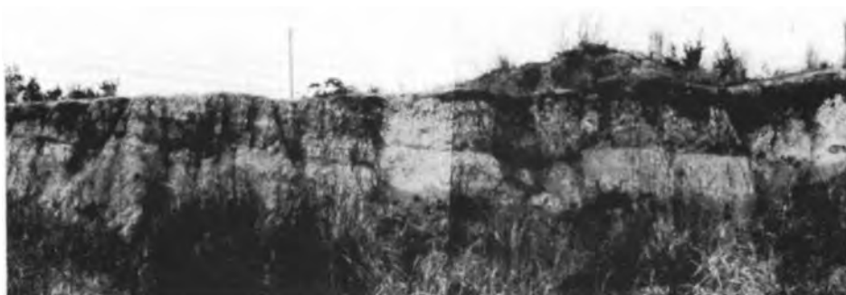
第43図 奄芸層群乱飛粘土層に発達する小断層 四日市市小山市の南部埋立処理場（地点755：第11図参照）
