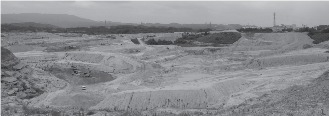
第 10.1 図 愛知県豊田市田村鉦山の露天採掘場 (2014 年 10 月撮影)
